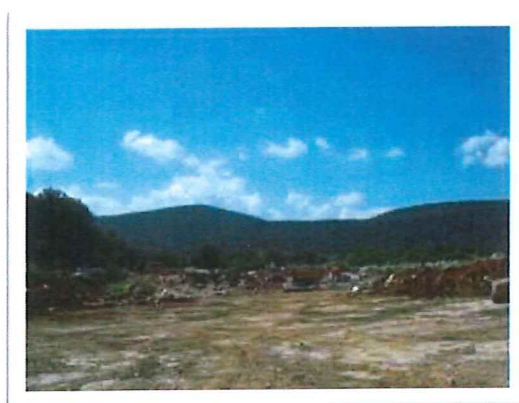
Surface défrichée et décapée, talus de terres de découverte en arrière-plan
