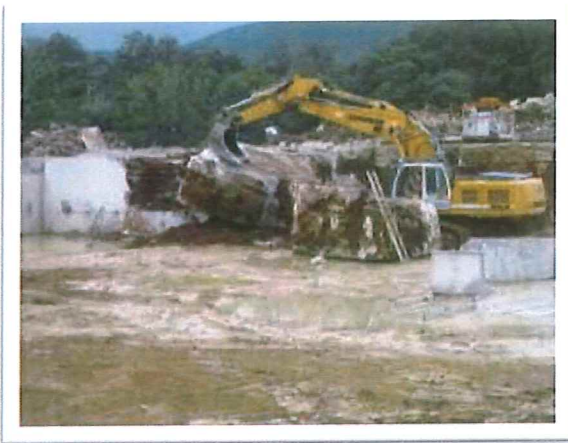
Une pelle prélève des blocs
